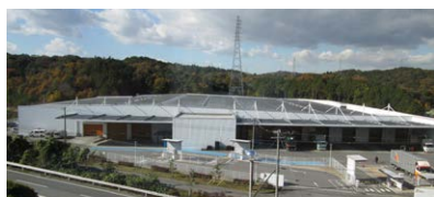
岡崎製作所（ストア棟）全景 屋上太陽光パネル
